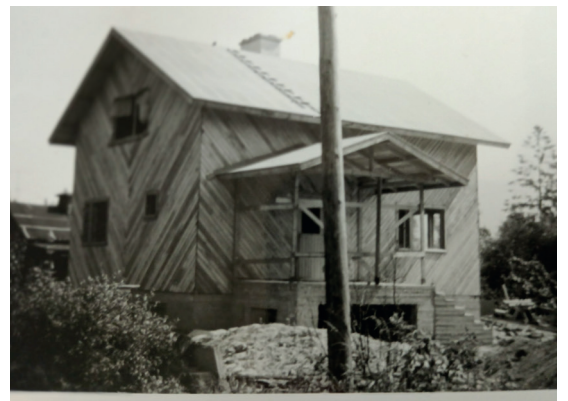
Erkki ja Sisko Hiltusen omakotitalo rakenteilla Simeonintien varressa v. 1961. Seinissä käytettiin aikakaudelle tyypillistä vinolaudoitusta.
