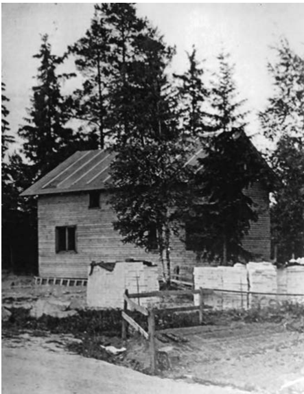
Kahilan talo rakenteilla Pohjolantie 11:ssä vuonna 1946. Kuva: Keijo Kahila
