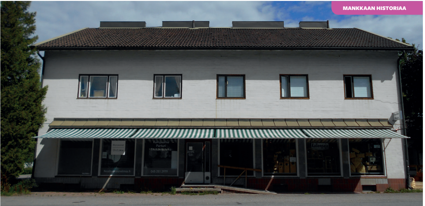
HOK:n vuonna 1948 valmistunut myymälärakennus Mankkaantien ja Torpparintien kulmassa.
